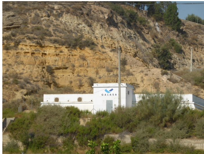
Depósito de agua de la Barriada de El Real
