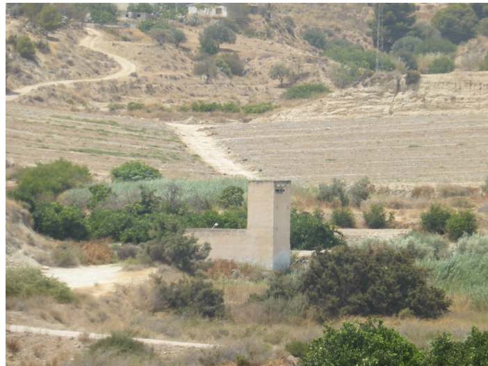
Sondeo y Caseta de Transformación Fuente Abad
