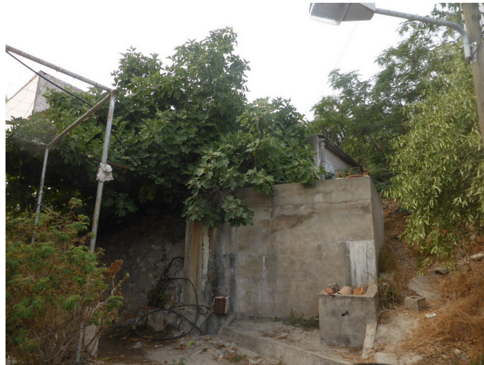
Depósito de agua 2 Barriada De Los Raimundos
