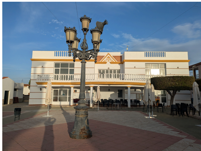
Terreno Centro de usos múltiples Aljariz
