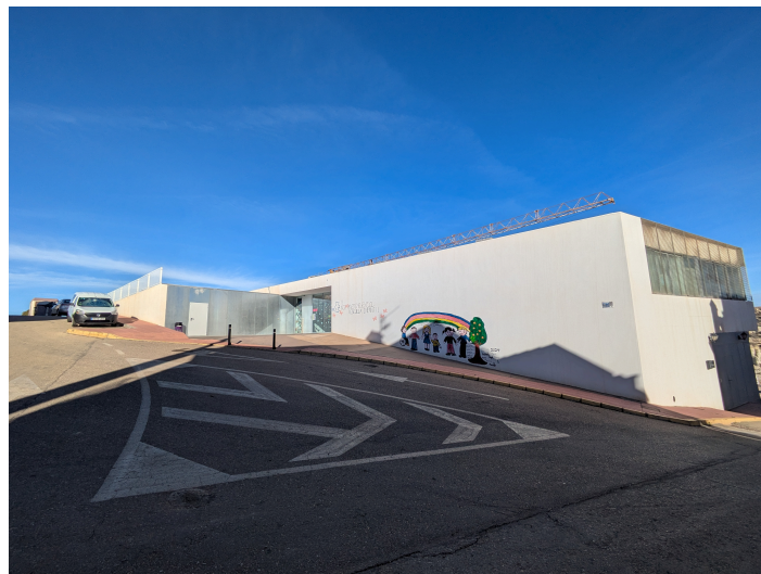
Terreno Guardería: Escuela Infantil La Pernerá y Sala de Ensayos
