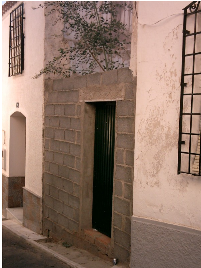
Solar en Calle Arrieros, 10
