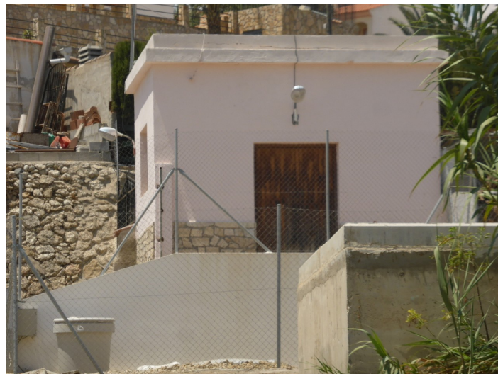
Depuradora Antigua E.B.A.R.
