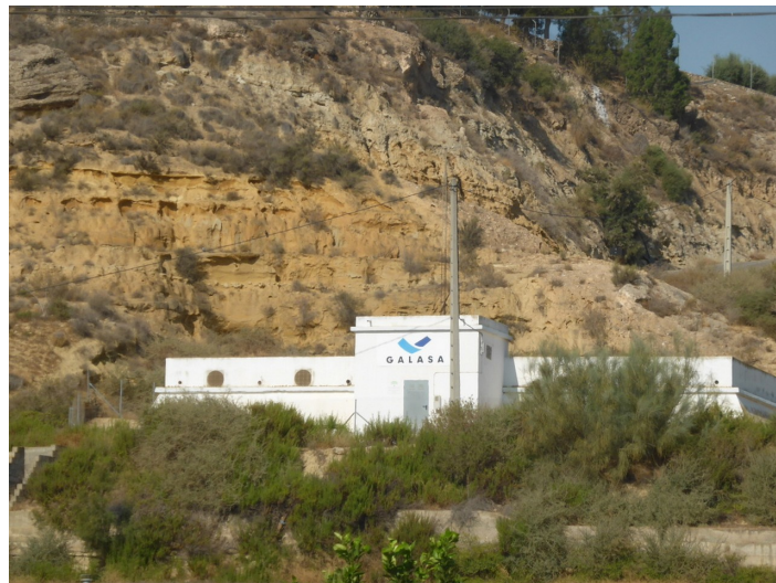
Terreno Depósito de agua de la Barriada de El Real
