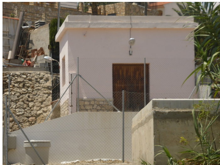
Terreno Depuradora Antigua E.B.A.R.
