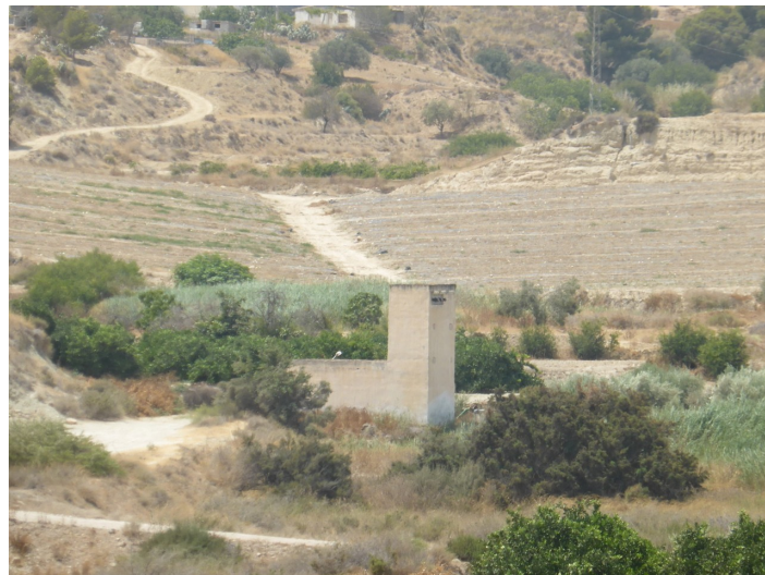
Terreno Sondeo y Caseta de Transformación Fuente Abad
