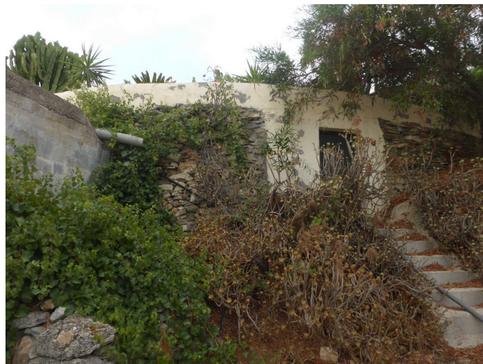
Terreno Depósito de agua 1 Barriada de los Raimundos
