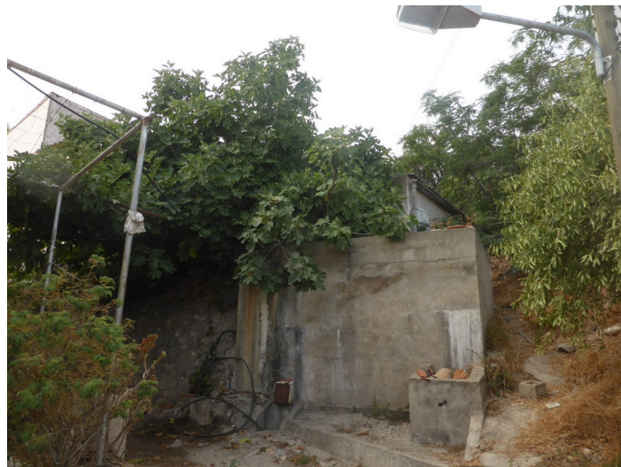
Terreno Depósito de agua 2 Barriada De Los Raimundos
