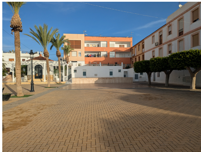
Terreno Servicios y vestuarios en la Era del Lugar
